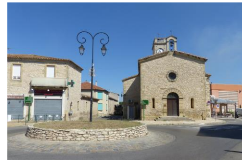
Le temple construit en 1842, autour duquel se développe un petit quartier faubourien dans la seconde moitié du XIXe siècle
