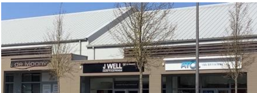
Enseignes parallèles au mur réalisées avec un panneau de fond, Magny-le-Hongre, Val d'Europe Agglomération, mars 2021.
