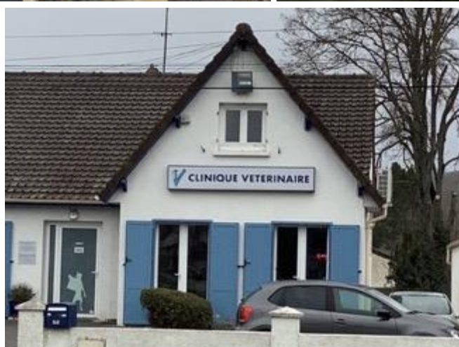
Enseignes parallèles au mur dépassant des limites de l'égout du toit, Coupvray, Montry et saint-Germain-Sur-Morin, Val d'Europe Agglomération, mars 2021.
