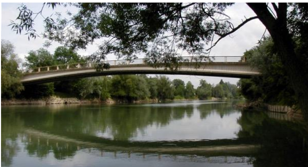
Pont sur la Marne à Esbly, source : monumentum.fr
