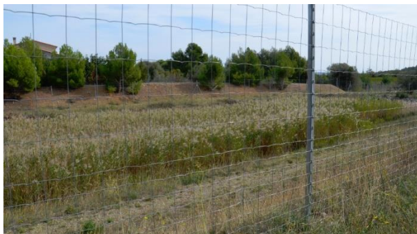
☞ Photographie : Bassin de rétention à l'Est
