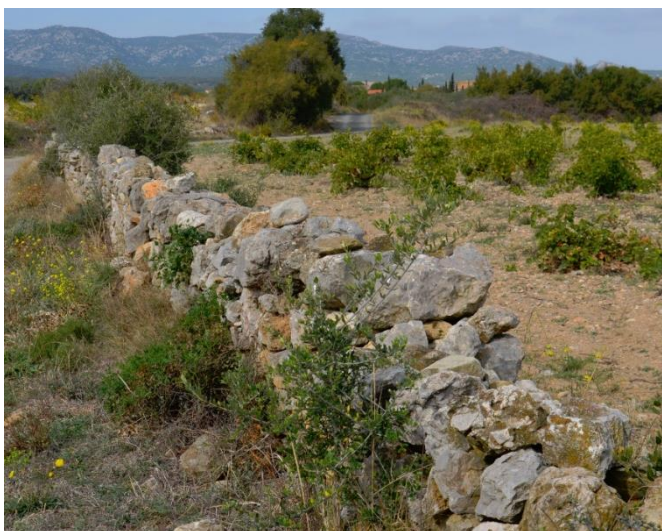
☞ Photographie : Muret en pierres sèches à l'Est
