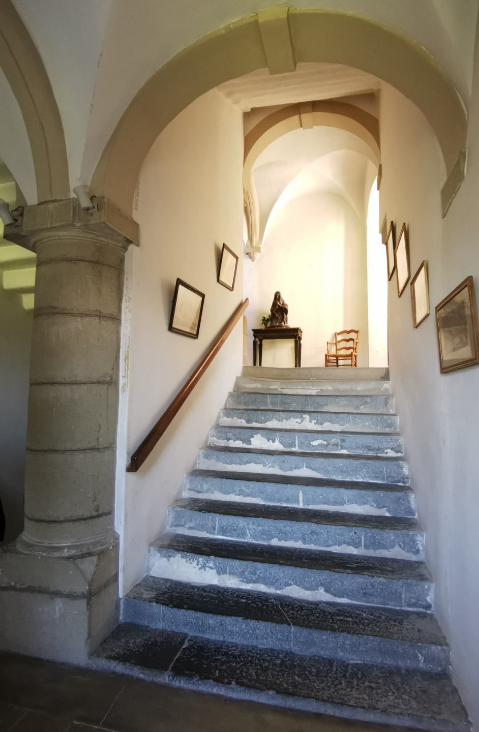
Escalier rampe sur rampe (XVII e s.)
