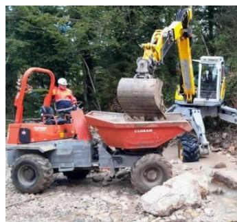
Travaux sur le Tacon ©R.Bellier-PNRHJ
