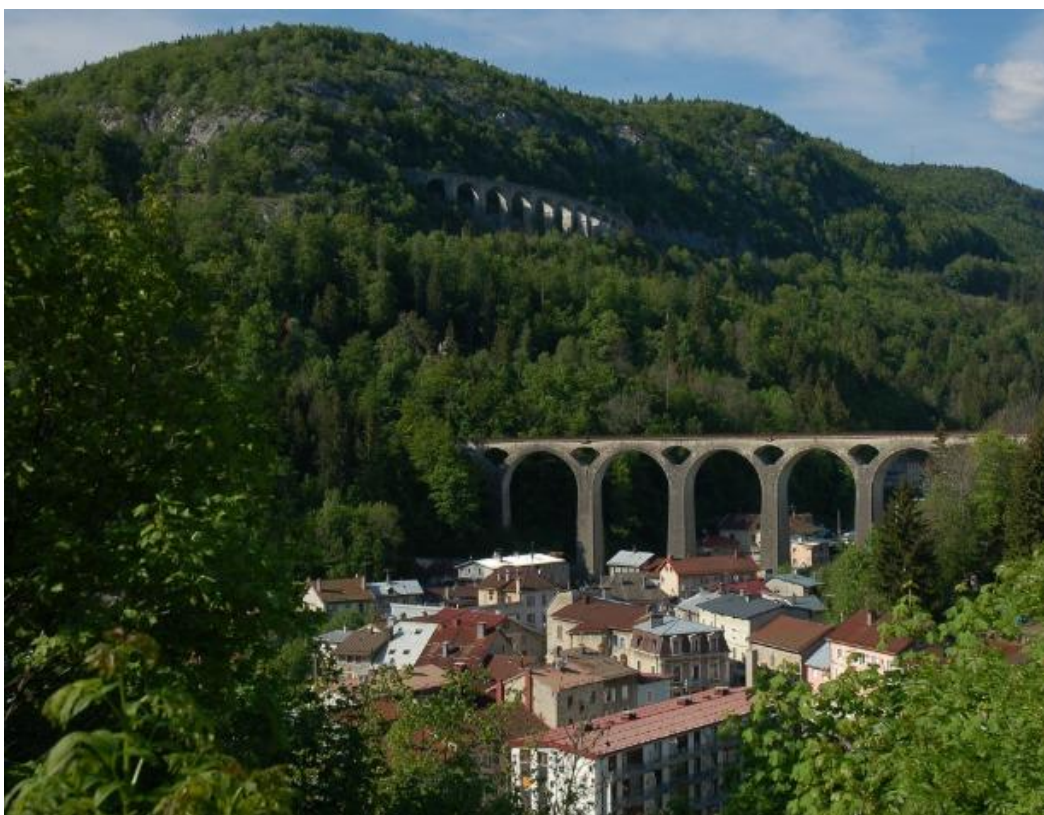
Viaducs de Morez ©PNRHJ
