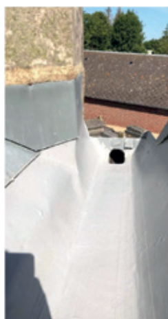
Suite à des fuites, l'étanchéité du chéneau de l'église a été intégralement refaite en 2022.
