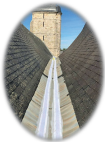
Suite à des fuites, l'étanchéité du chéneau de l'église a été intégralement refaite en 2022.
