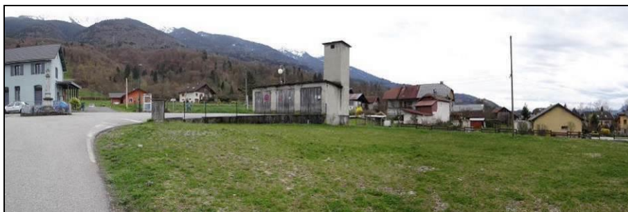
Photo 5 : Partie des terrains objets de l'OAP au Sud et carrefour devant la mairie depuis la route arrivant sur la mairie, en direction du Sud-Est
