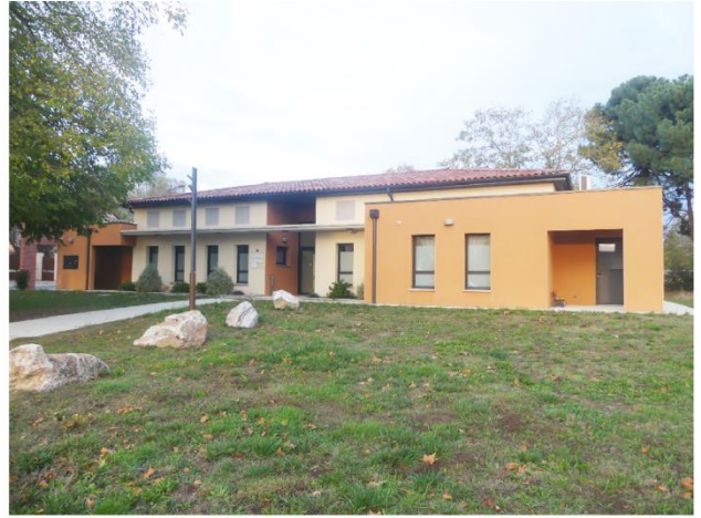
Maison médicale, façade ouest
