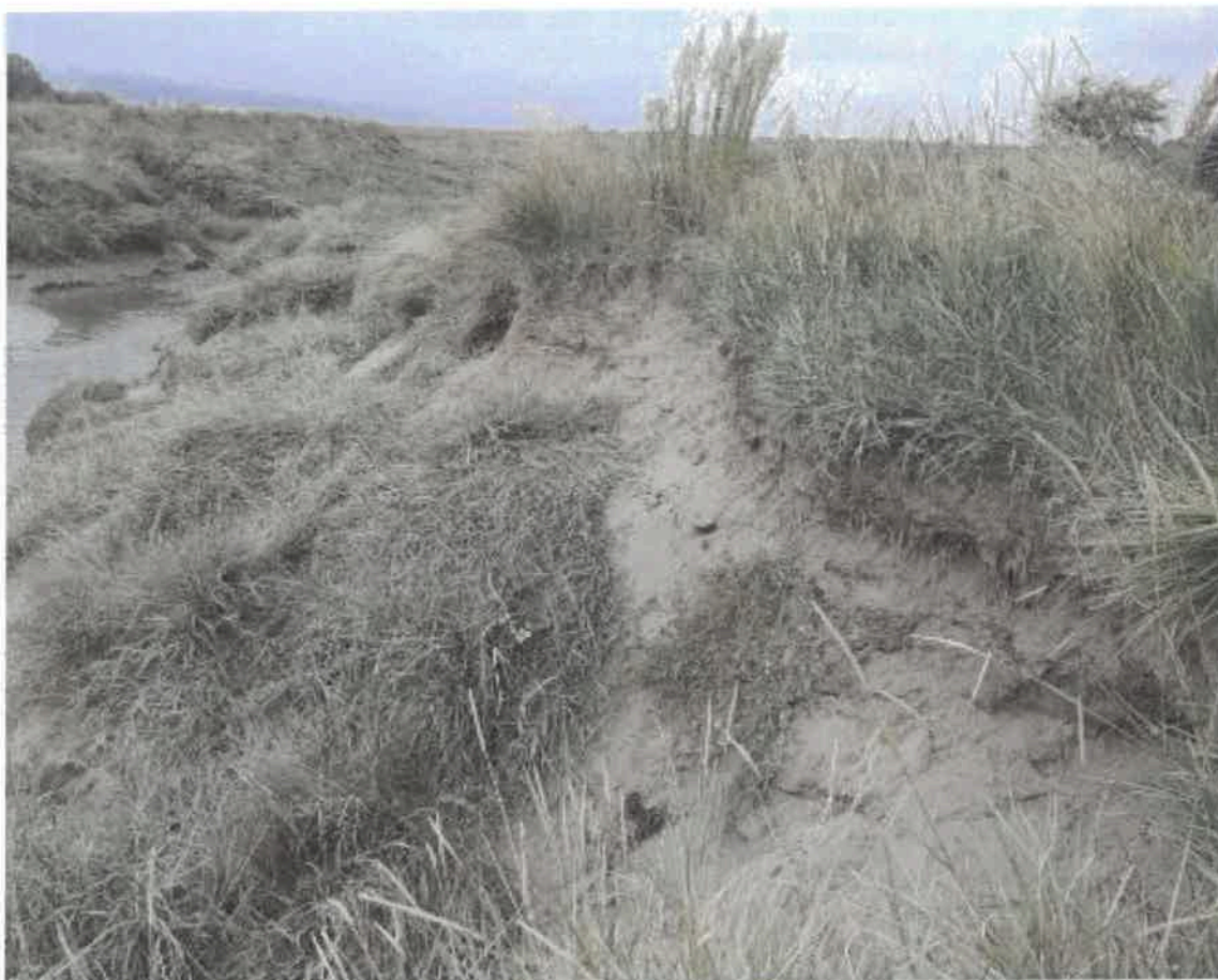
Glissements de terrain sur une digue en terre victime de l'érosion. Elle pourrait alors s'effondrer complètement lors de la prochaine crue du cours d'eau.
