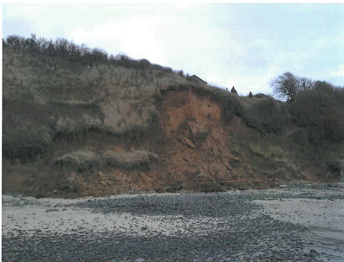
Un glissement de terrain sur la plage de Lermot en Mars 2014. (Photo : SBAA)
