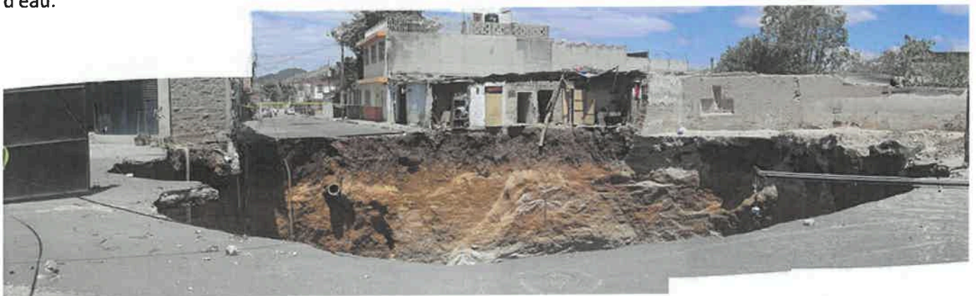
Cratère d'effondrement géant (20 m de diamètre et près de 60m de profondeur) à Guatemala city au Guatemala, causé par la dissolution de la roche calcaire sous-jacente.
