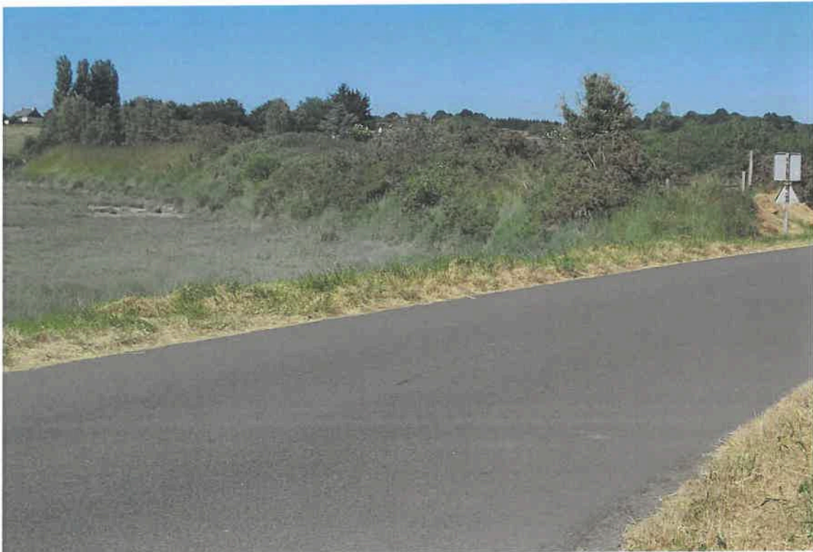
Une levée en terre au niveau de la Rue du Houlet (photo : SBAA)
