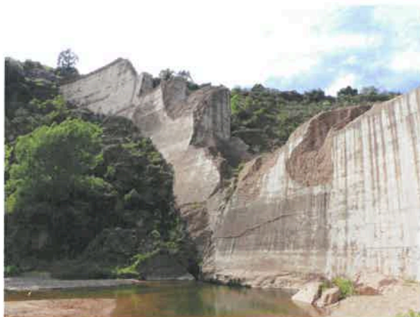
Restes du barrage de Malpasset à Fréjus (Var).
