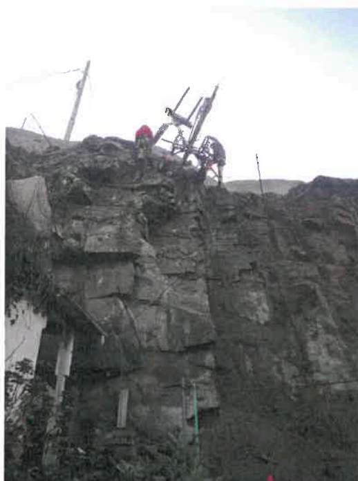
Travaux de confortement sur un pan de falaise sujet à éboulements
