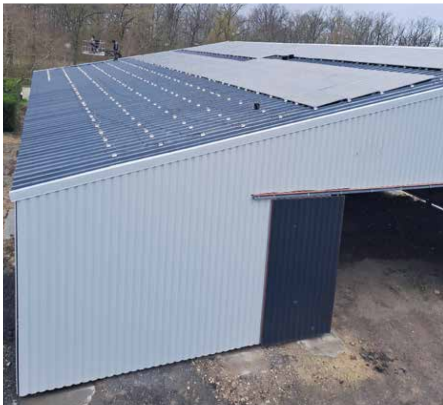
Installation des panneaux solaires du hangar photovoltaïque
