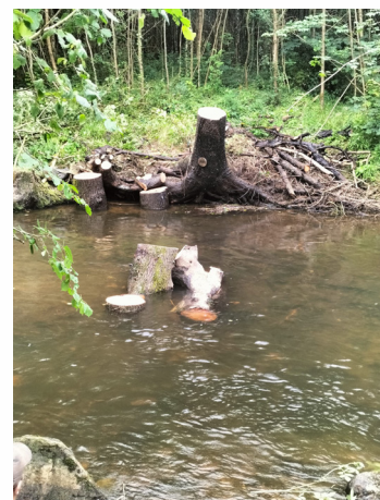
Photo après la fin des travaux
