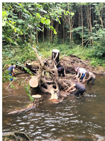
Photo en cours de travaux
