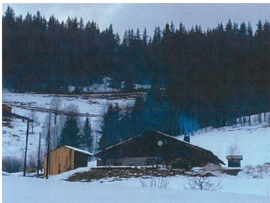
Bâtiment 6 - parcelle B375
