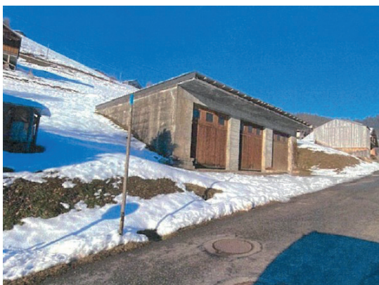
Bâtiment 10 parcelle B2167
