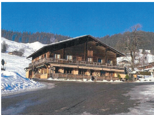
Bâtiment 11 parcelle B277
