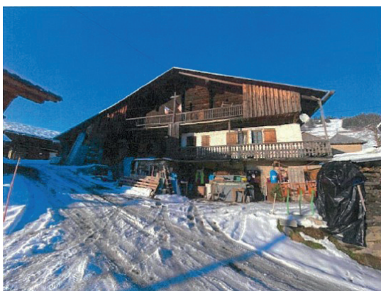
Bâtiment 3 - parcelle B105
