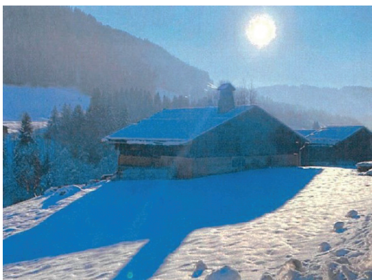
Bâtiment 7 - parcelle B387
