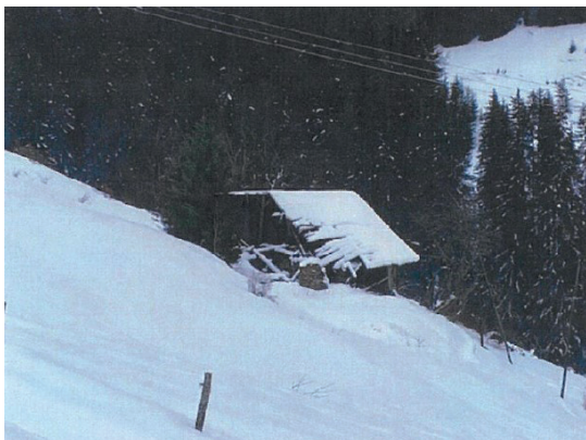
Bâtiment 14 parcelle B815
