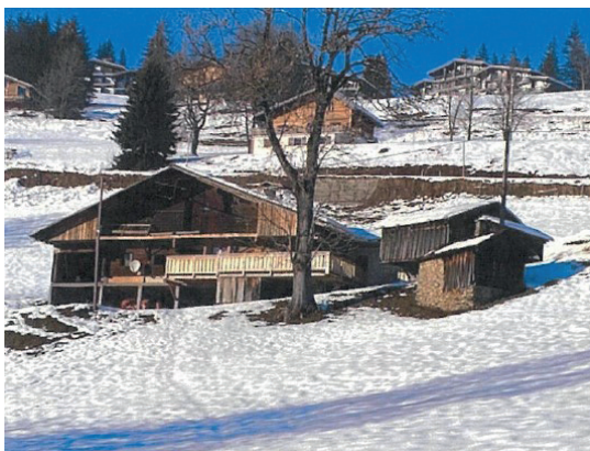
Bâtiment 5 parcelle B172
