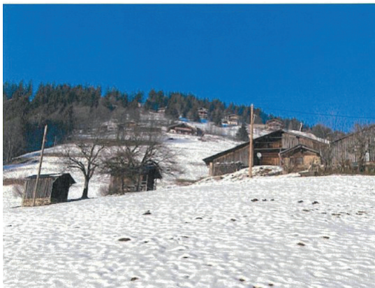
Bâtiment 2 - parcelle B110
