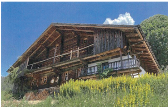
Bâtiment 8 - parcelle B1858
