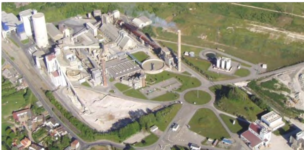
Figure 19. Site de la cimenterie EQIOM à Lumbres (eqiom.com)
