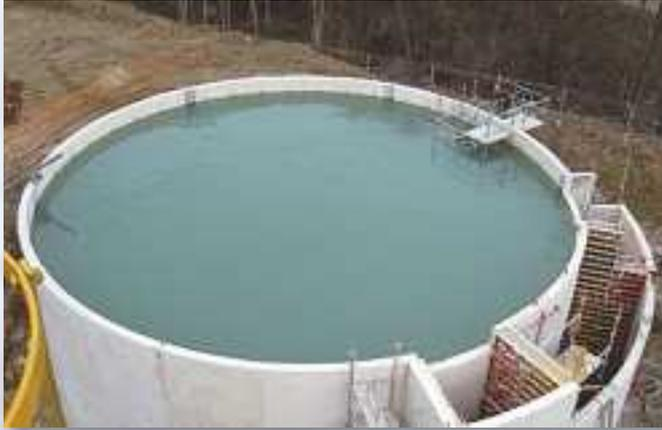
Test d'étanchéité sur un bassin
