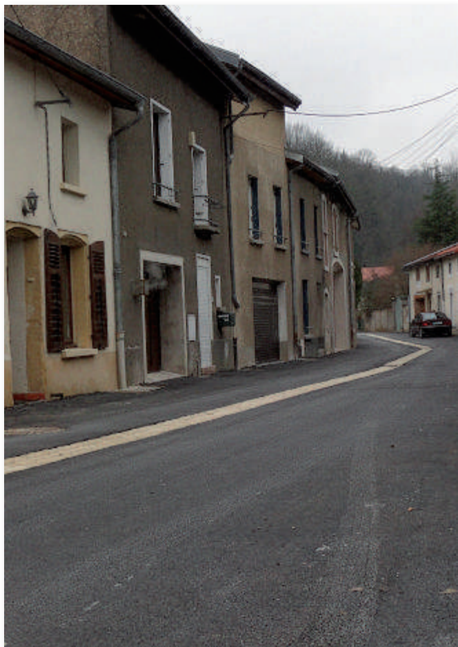
Une fois la réfection terminée, une zone piétonne le long des maisons sera matérialisée par une bande blanche avec interdiction de stationner.
