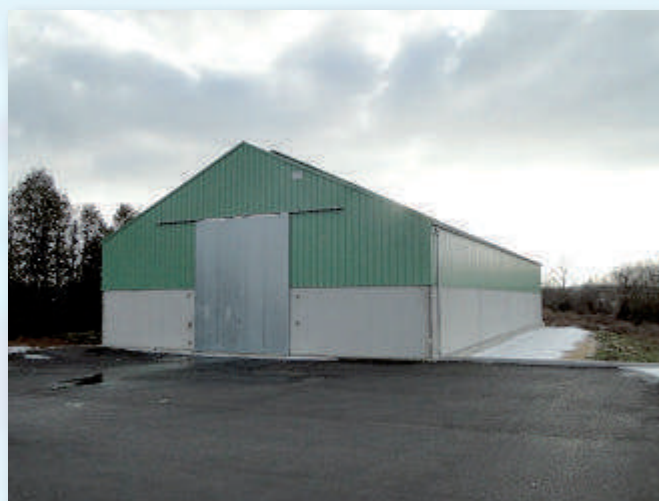
Aire à boue, route de Griscourt. Les boues y sont stockées, analysées avant leur épandage.
