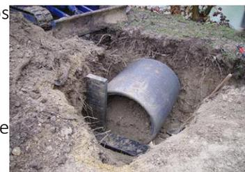
Figure 12 : Pose d'un tuyau en béton suite à un effondrement de berge (Crédit : www.cscf.ch)
