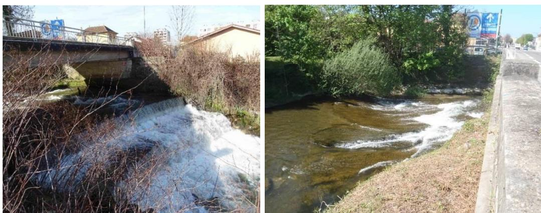
Figure 7: Radiers béton et rampe en béton en aval et en amont du Pont de Ruy à Bourgoin-Jallieu (Crédit : M. Hugon, Burgeap)
