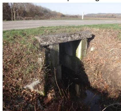
Figure 6 : Ouvrage non adapté au passage de la faune terrestre, à la confluence entre le canal de Villieu et le canal de Saint-Savin (S. Vanel, 2019)
