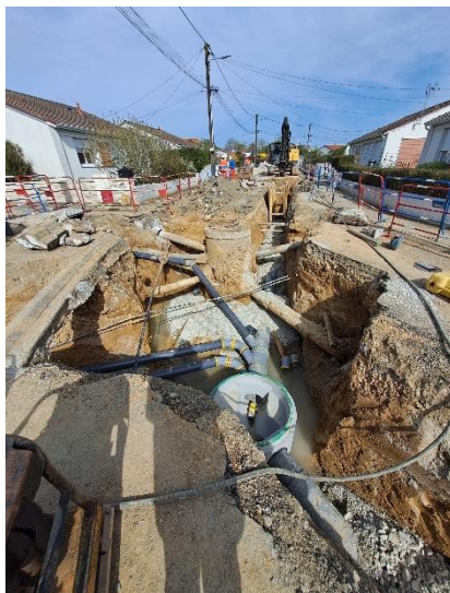
Travaux de mise en séparatif du réseau d'eau usée – Quartier Fief des Pommiers - Clisson
