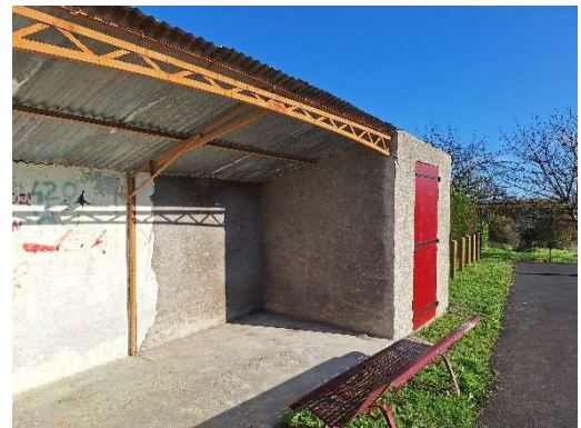
Le petit abri est en cours de rénovation
