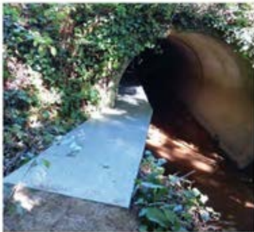
⑩ Exemple de raccordement à la berge. Source : Cerema.
