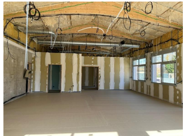
La grande salle en chantier
