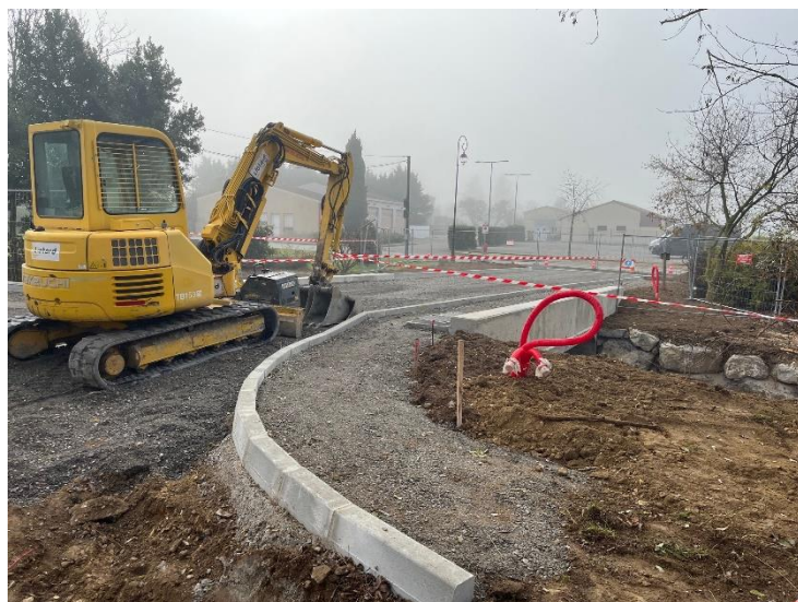
Construction du pont sur le Bost
