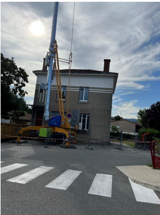
Début du chantier avec le bâtiment de l'ancienne poste
