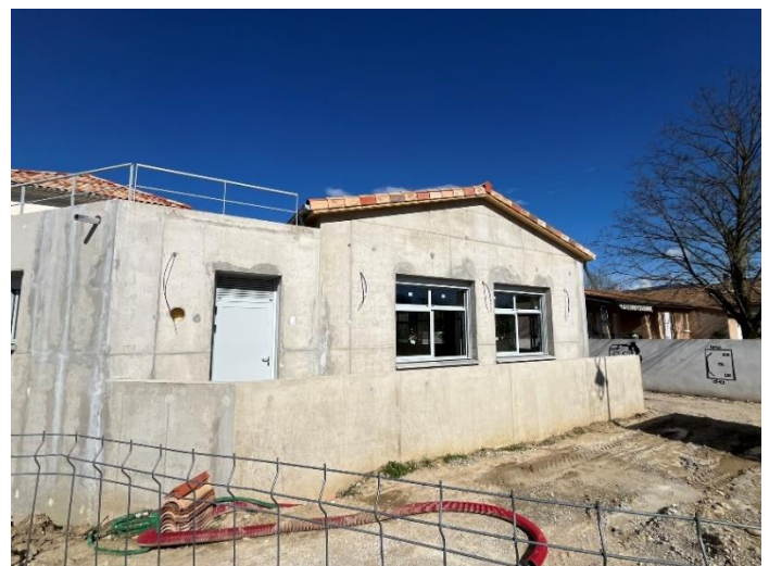
Le nouveau bâtiment en construction
