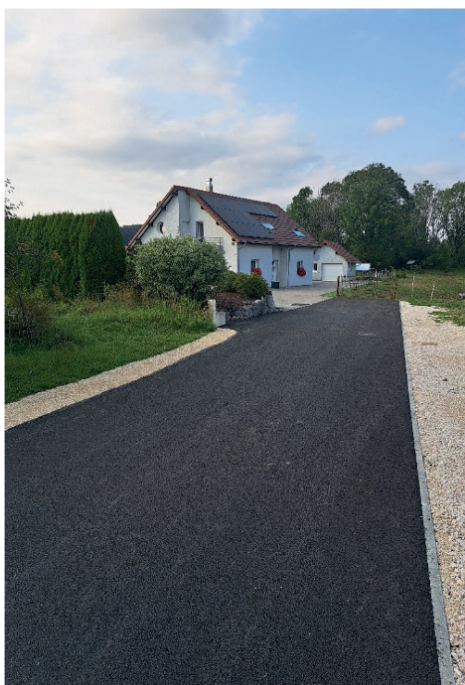
Réfection de la voirie au Fort Chabrol
