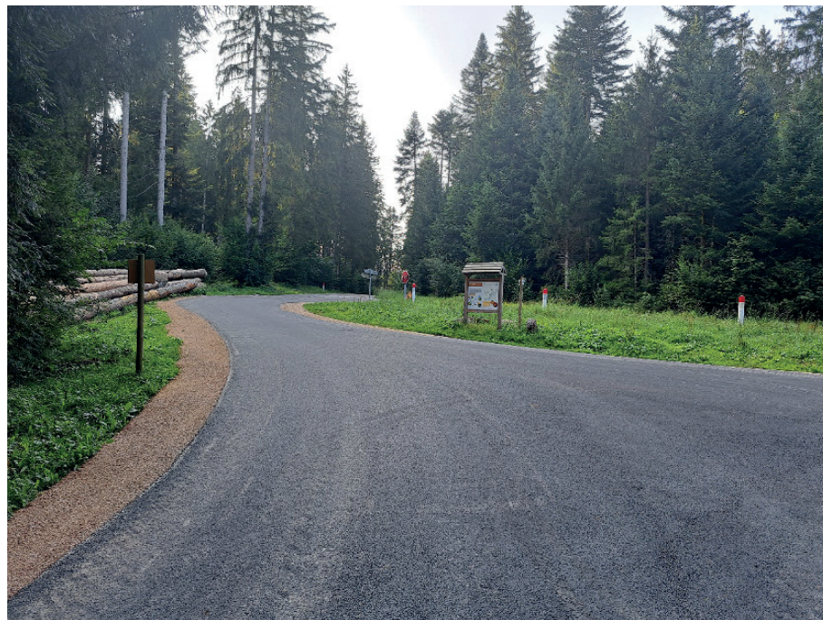
Réfection du chemin Sur les seignes
