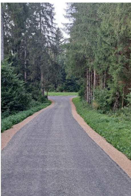
Réfection du chemin Sur les seignes
