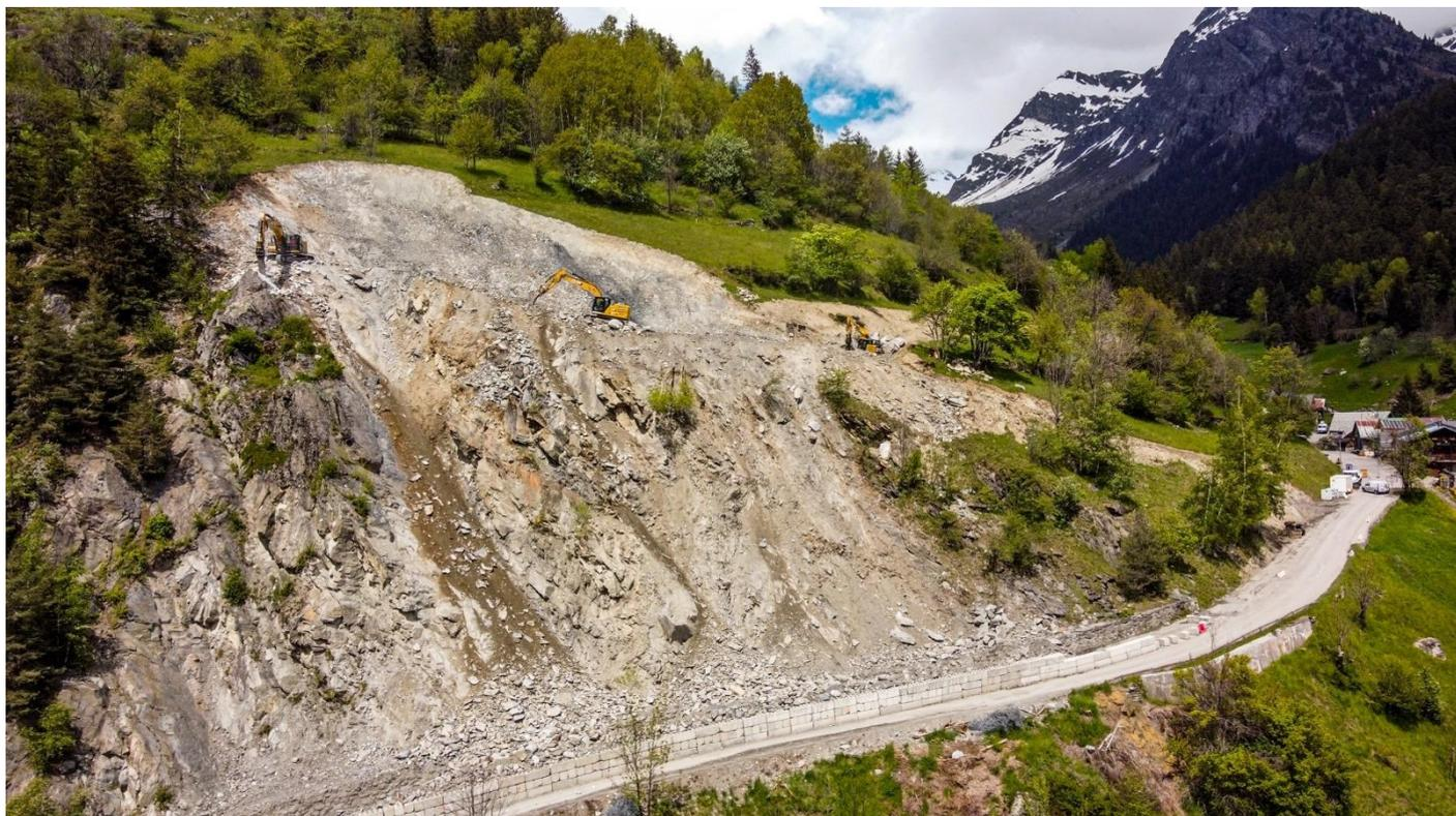
**1<sup>er</sup> juillet 2024** - Le chantier entre dans une phase de transition, les gros terrassements sont terminés, la pose des grillages peut commencer. Par conséquent, le régime de circulation au droit du chantier est modifié. C'est la fin des périodes de fermetures (8h15 à 12h15 et 13h15 à 17h15) et la RD84 est désormais ouverte 24h/24 en alternat par feux.
