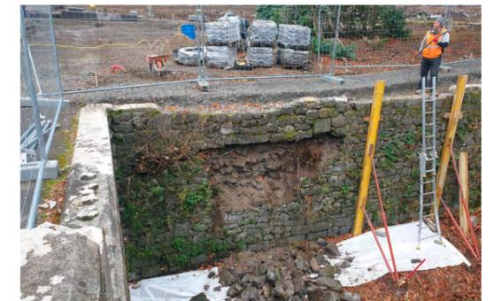
Lors des travaux de restructuration du parc, une partie du mur s'est écroulée sur la berge de la Dordogne.
