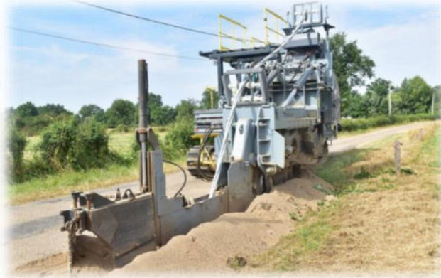
Travaux avec trancheuse
