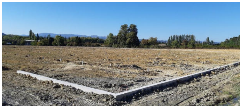
Figure 23 - Fondations béton extérieures (longrine). Source : Reden.
