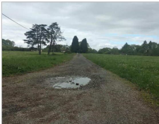
Photo 11 : Surfaces artificialisées © Rainette, 2024
