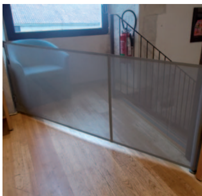
Aménagement d'une barrière de sécurité
