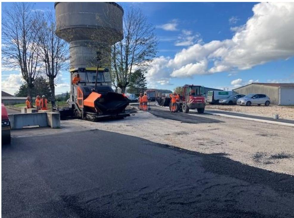
Travaux d'enrobés autour du château d'eau, rue de Paris, avec aménagement et sécurisation des places de parkings, ce qui permet de ralentir la vitesse des véhicules.
