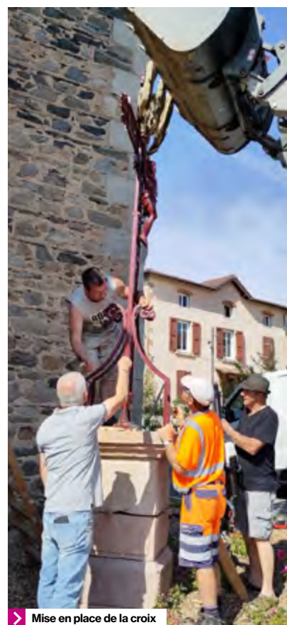
➤ Mise en place de la croix
