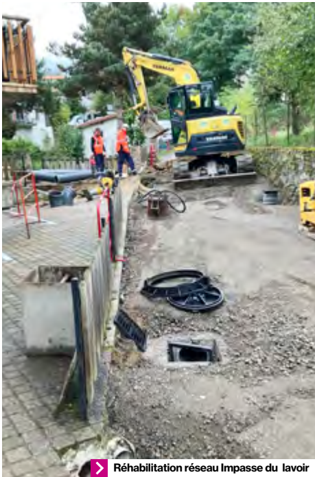
➤ Réhabilitation réseau Impasse du Lavoir
