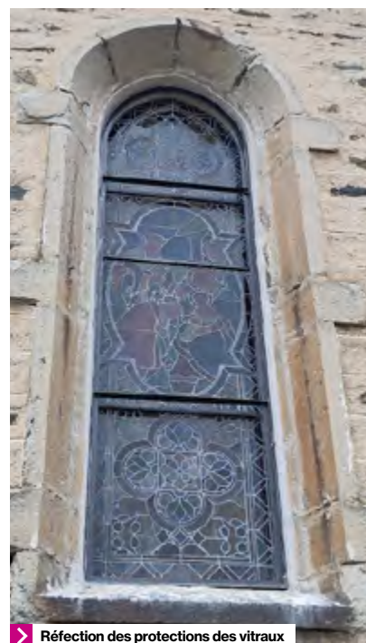
➤ Réfection des protections des vitraux
