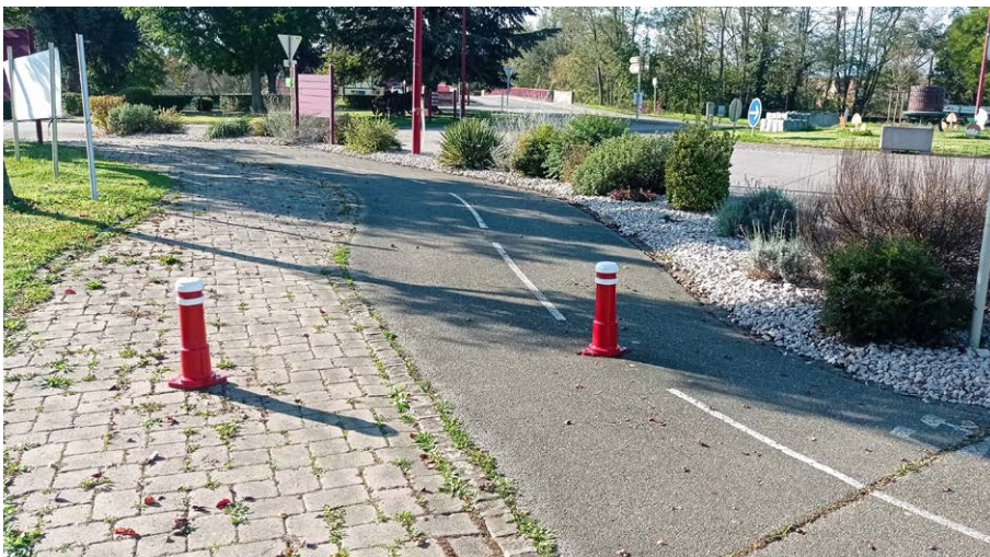
Mise en place de plots de sécurité route dans le village
