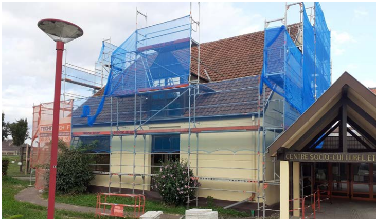
Renforcement et isolation de la toiture et pose de panneaux photovoltaïques au CSCS
