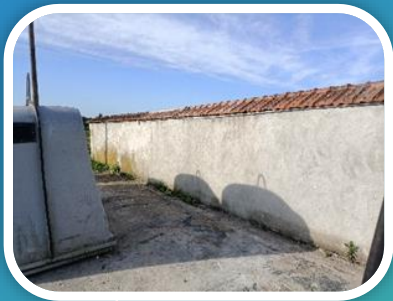
Reprise mur cimetière
