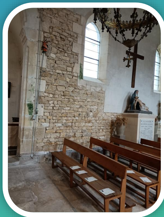
Reprise enduit à la chaux église
