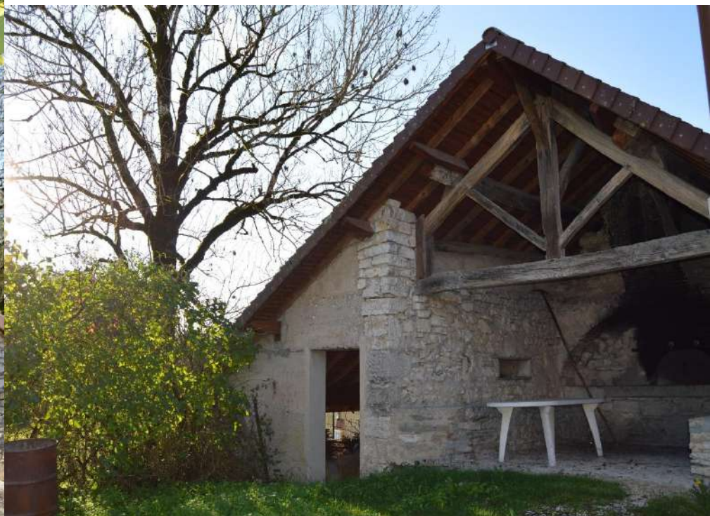
Travaux de réfection du four en 2011
