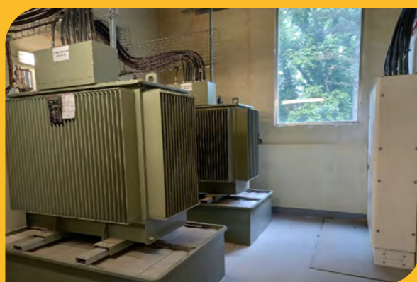
Remplacement des transformateurs 20KV/3V par des équipements 20KV/690V basse tension
