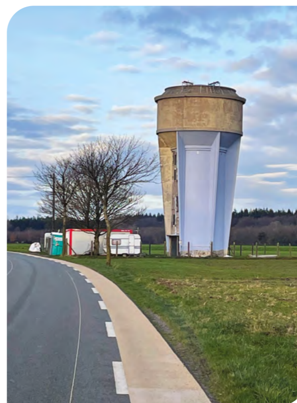
Château d'eau de Quercamps en cours de réhabilitation
