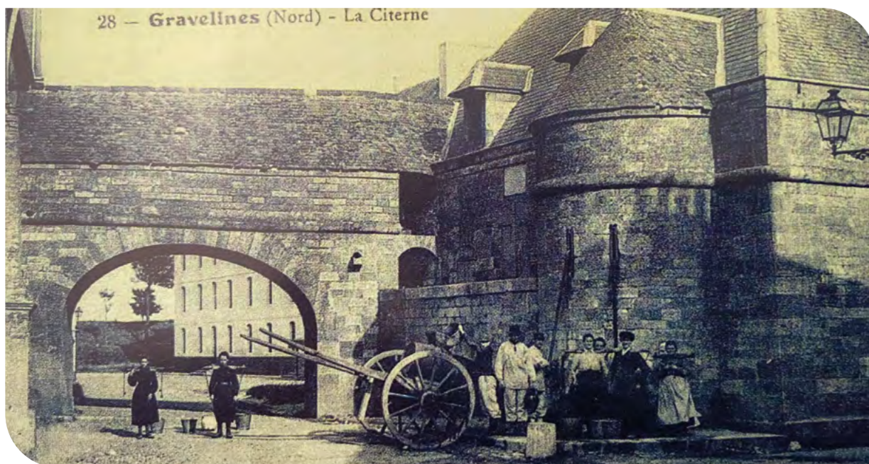
Photographie de la citerne de Gravelines. Cette citerne permettait de recueillir l'eau pluviale.
