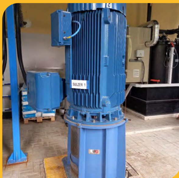
Renouvellement de la pompe Sulzer n°1 de la station de refoulement de Moulle
