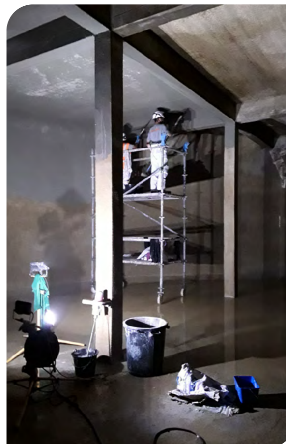
Réhabilitation des bâches de refoulement
