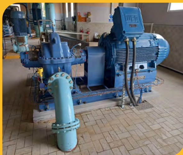
Réhabilitation de la pompe Worthington
