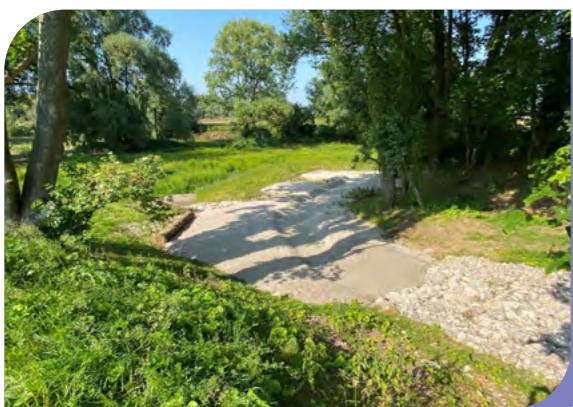
Figure 4 vue des bassins de phytotraitement
