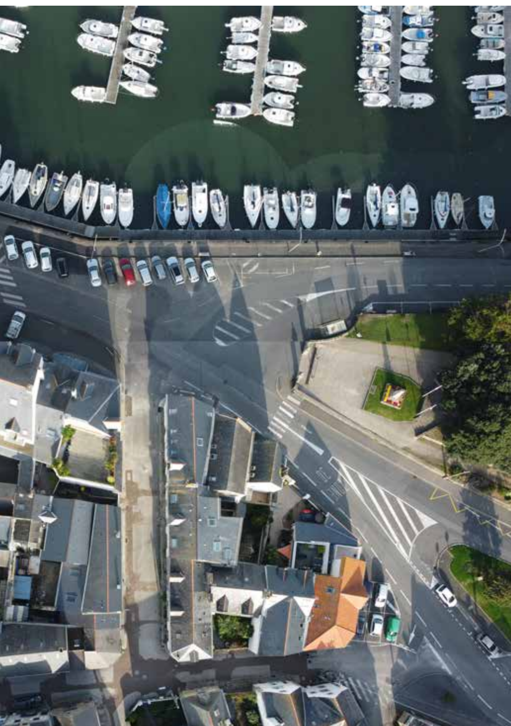
Photo montage du quartier Dinan concerné par les travaux de requalification.
