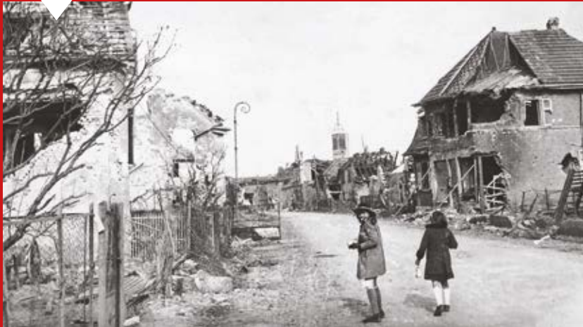
Destruction du centre-ville de Wittelsheim
