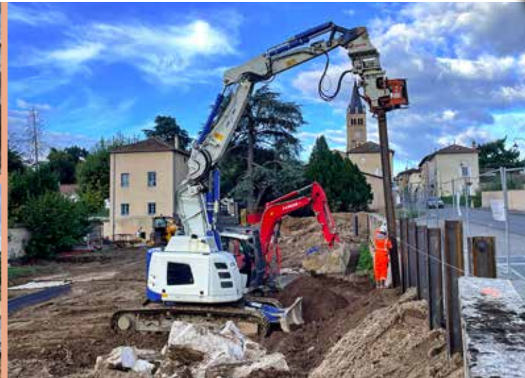
Renforcement de la RD86 à l'aide de pieux métalliques
