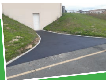
Bitume au stade
