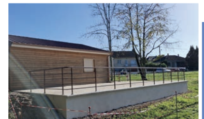
Pose d'un Garde Corps au Chalet de la Pétanque
