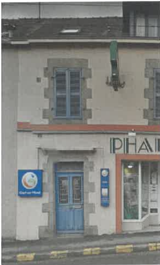
Exemple de façade avec commerce en RDC. La porte d'entrée du logement est préservée.
