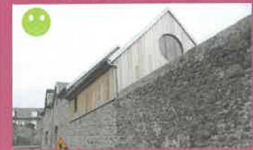
Réutiliser les murs traditionnels dans les projets
