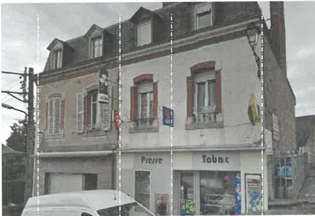
Exemple de lecture de verticales structurantes.
