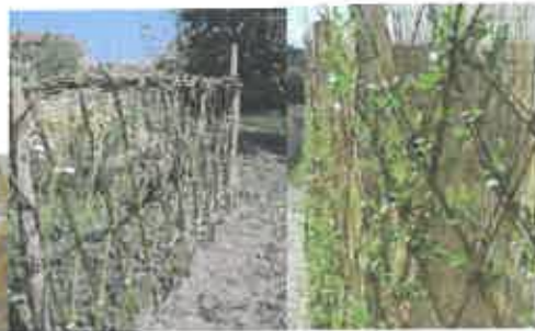
Fascine / tressage d'osier vivant
