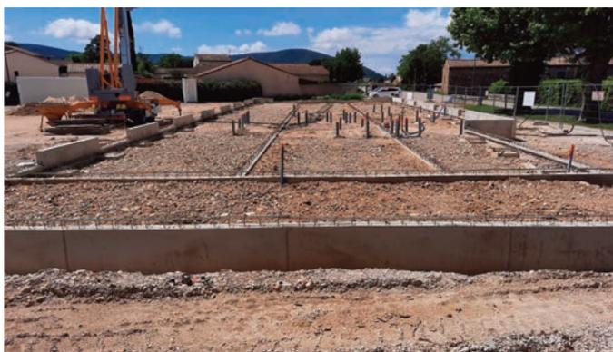
Fondations, soubassements, dalles verront prochainement accueillir les structures bois des murs puis des charpentes ainsi qu'une couverture avec des panneaux photovoltaïques. Ouverture prévue en janvier 2025.
