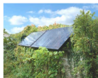
Les capteurs thermiques sont adossés à un mur du jardin. Cette solution demande une surveillance de la croissance de la végétation pour éviter toute ombre portée. Vigny (Val d'Oise) © PNR du Vexin français
