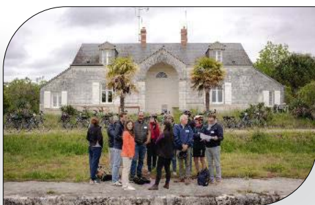
© Yoan Jäger-Sthul – Maison éclusière
