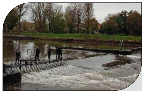
© NEC – Abaissement Bléré
