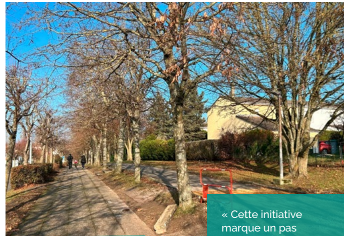
Avenue Viaud Chemin piétonnier et voie cyclable refaits à neuf
