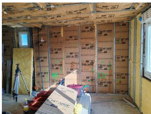
Isolation thermique et phonique
