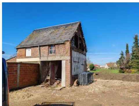
Démolition d'un ancien bâtiment pour la création d'un local et d'un parking privatif
