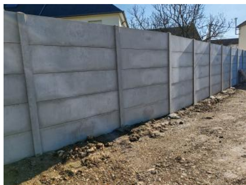
Réhabilitation des clôtures
