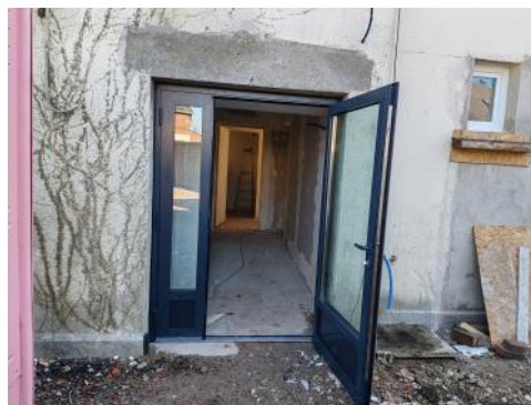
Modification des menuiseries et des cloisonnements pour faciliter l'accès PMR
