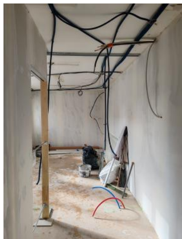
Mise aux normes des différents flux (électriques, réseaux et chauffages)
