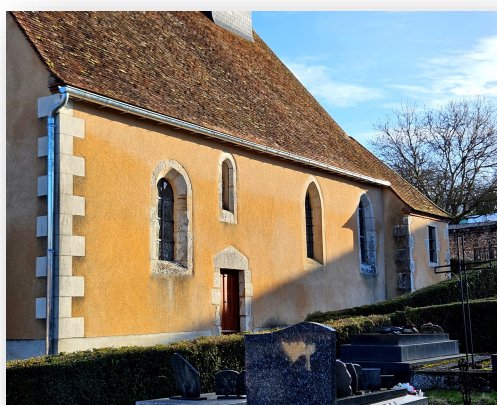
Gouttière de l'Eglise
