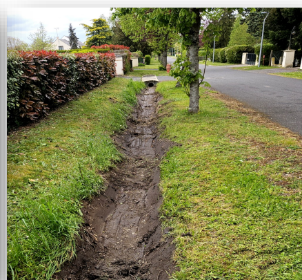
Curage des fossés
