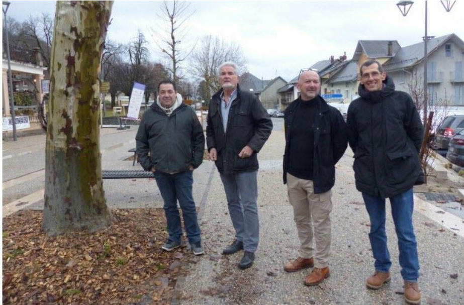
Les élus et les techniciens sur le chantier de requalification du centre bourg. Photo Le DL/B.M.
