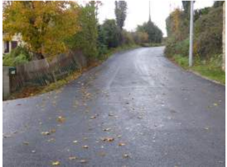
Réfection en enrobé du revêtement de la rue du Métras. Le chemin des Combettes sera refait en bicouche au printemps.
