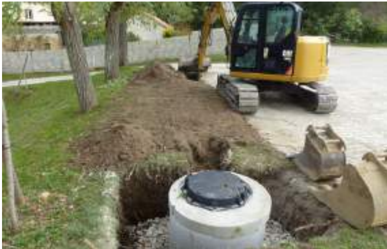
Infiltration des eaux pluviales au parking du restaurant scolaire pour éviter le ruissellement sur la voie d'accès.
