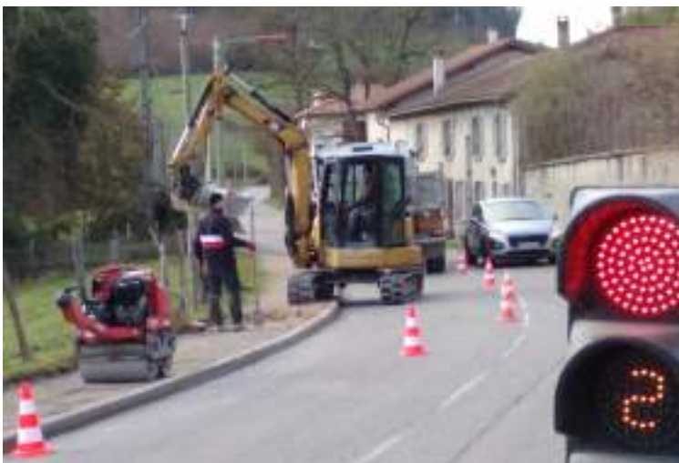
Remise en état du trottoir le long du CD 53 jusqu'au gymnase
