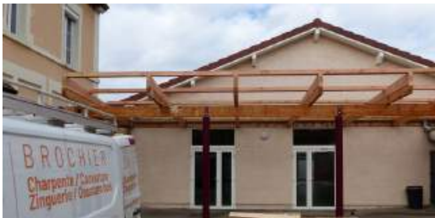
Entretien de bâtiments communaux : Pente des translucides de la salle d'évolution de l'école relevée. Lasurage des bandeaux de la salle municipale et de l'église.
