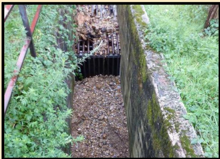
Un ouvrage avait été aménagé au bord de la route départementale pour retenir les embâcles. Son colmatage laissant déverser l'eau en direction du hameau du Revollet, la commune, sur préconisation du SIRRA, a fait remplacer un muret par une grille verticale pour favoriser l'écoulement sous la route départementale.
