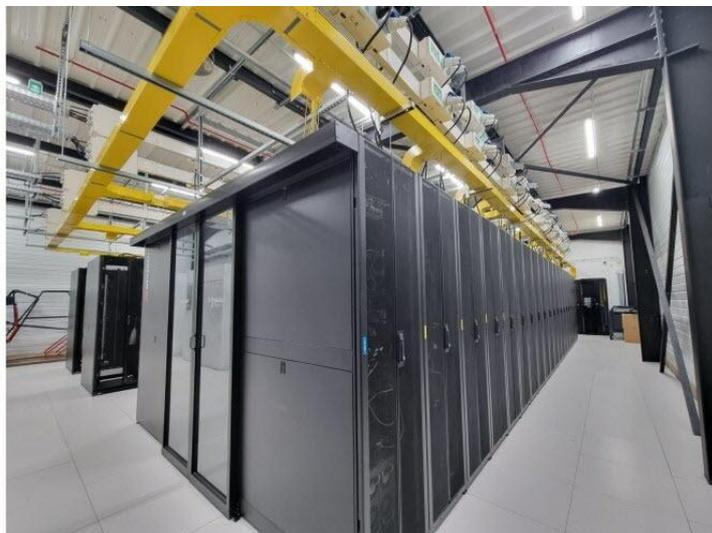
L'intérieur du data center de Reventin-Vaugris. La température y est stable été comme hiver et le refroidissement se fait avec de l'eau glacé en circuit fermé. Photo Le DL/Georges Aubry
