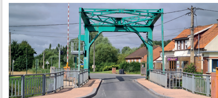
Mise en sécurité des ponts
