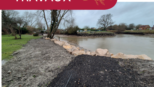
Secteur du Clairmarais, protection des habitations
