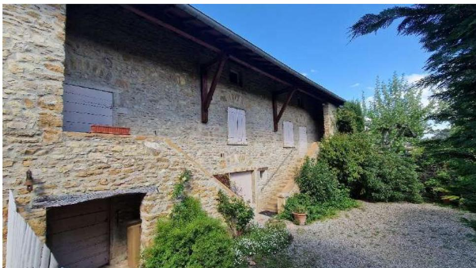
Des « corbeaux », sortes d'équerres en bois fixées au mur et non au sol, soutiennent l'avant-toit.
