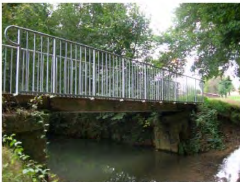
Guereins : passerelle OA11 en aval de la RD88
